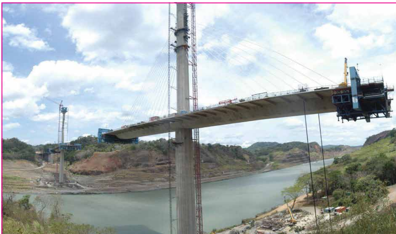
Realizzazione del "Second Bridge over the Panama Canal – Republic of Panama" per cui EUROPRESS ha fornito i componenti oleodinamici che sostengono i segmenti per la realizzazione dell'impalcato del ponte. (Panama, Luglio 2003)
