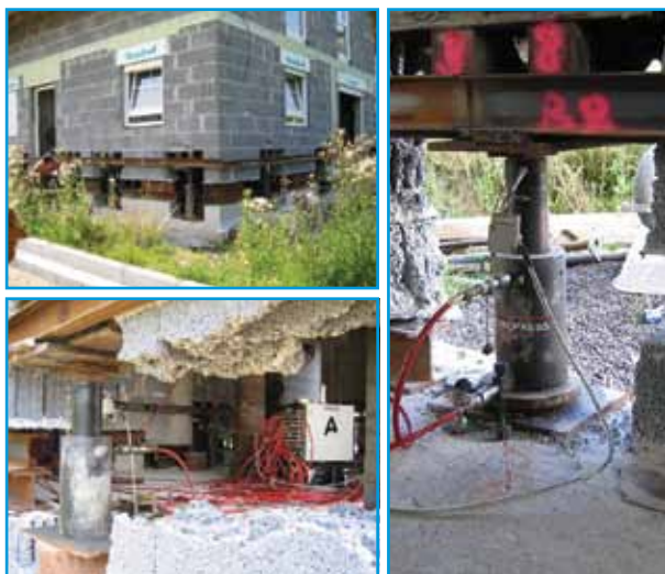
Sollevamento sincrono con Synchronlift per la ricostruzione delle fondamenta di una casa. (Germania 2003)
